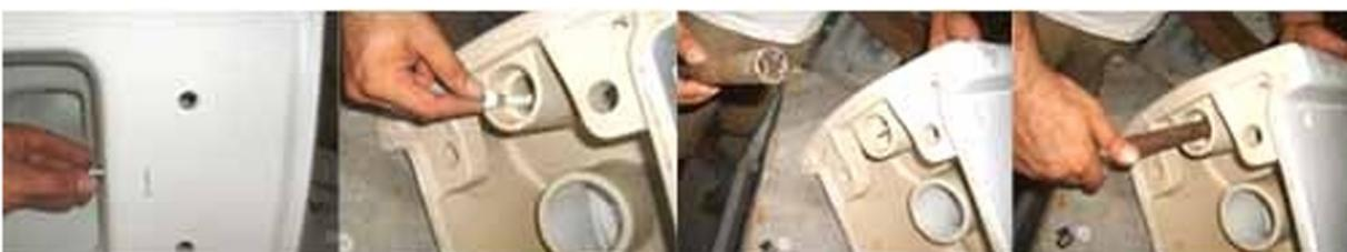
Trysku vložte do otvoru z vnitřní části wc mísy. Ze zadní strany prostrčíme zbývající část a našroubujeme. Dotáhneme trubkovým klíčem tak, aby tryska těsnila.
