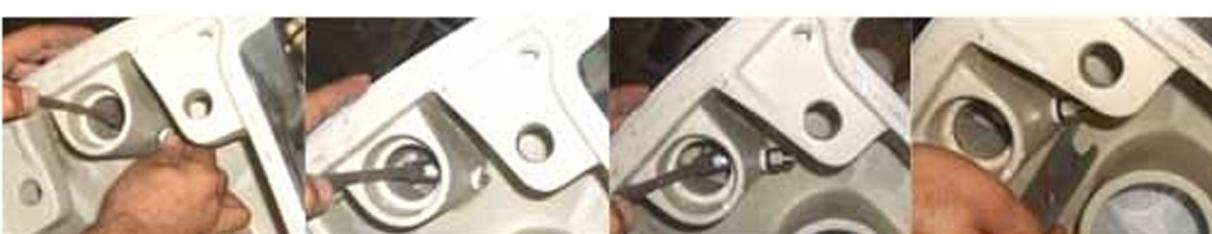
Na vyčnívající šroubení nasadíme těsnění - zúženou stranou směrem ke keramice. Následně osadíme matku a dotáhneme. Nasadíme rohové šroubení pro přívodní hadičku.
